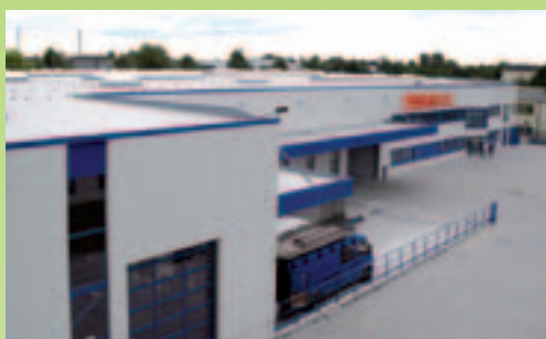
... und ISEKI-Produktions- und Lagerhalle, Fertigstellung 2008
